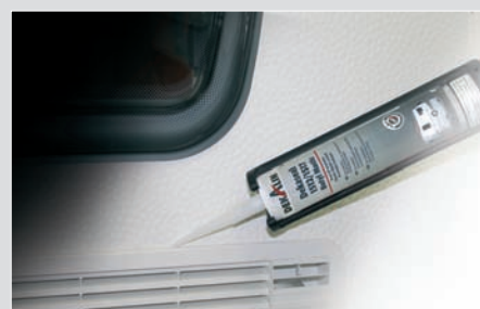
Abdichten von Seitenverkleidungen/Lüftungsgitter
